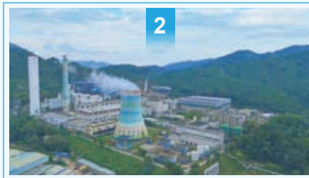
2 YUNNAN GREEN ENERGY 云南昆明西山
